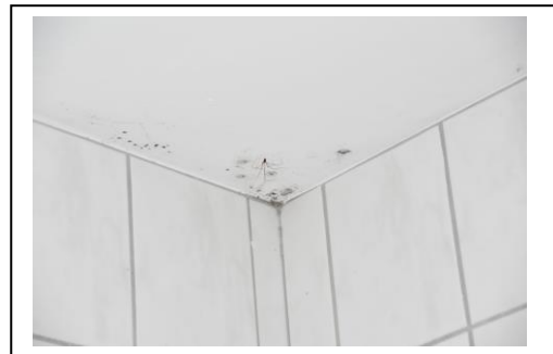
Abb. 2 Kleiner mikrobieller Schaden Quelle: Robert Kussauer
