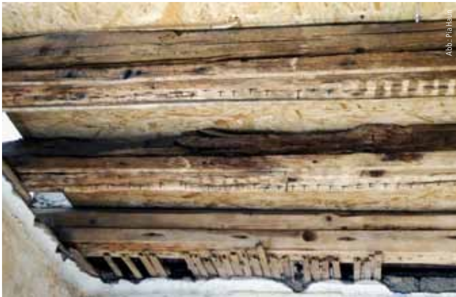
Abb. 6: Eine nachträgliche Abschottung ist oft aufwendig und teuer, da Vorarbeiten unerlässlich sind: Reinigen von Oberflächen und Schließen von Rissen. Hier sind vor dem Einbau der Abschottung außerdem noch Nägel zu entfernen.
